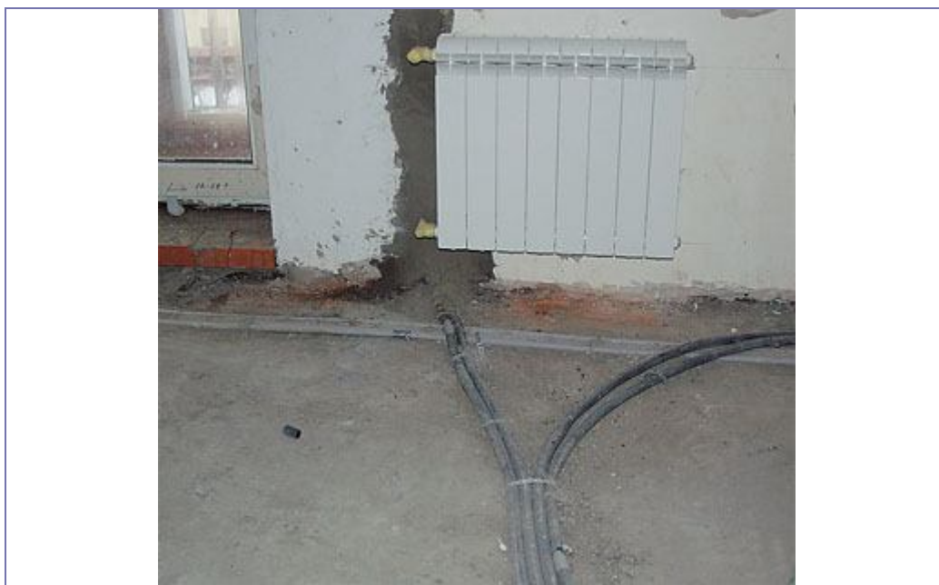
Подключение отопительных приборов при лучевой разводке в полу
